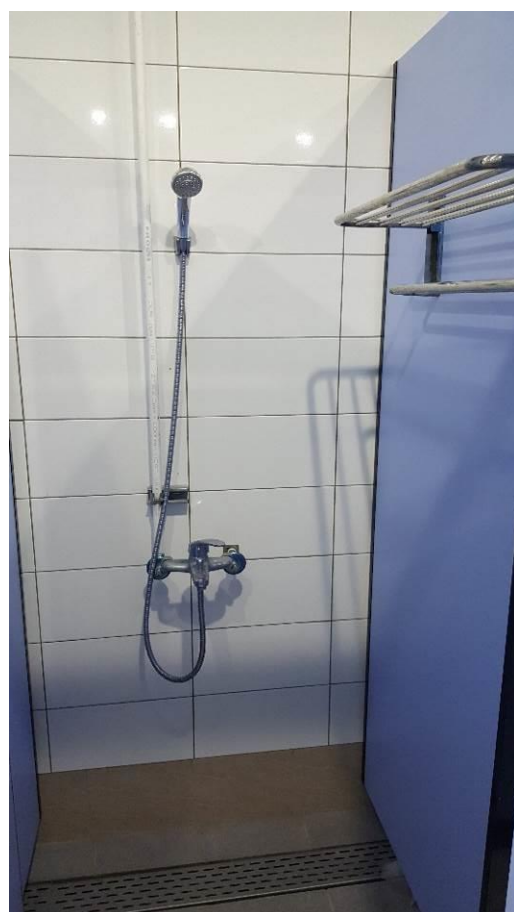
淋浴隔間內部設施
